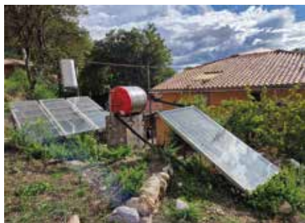
Prüfung der Solaranlage und Zustandsaufnahme
