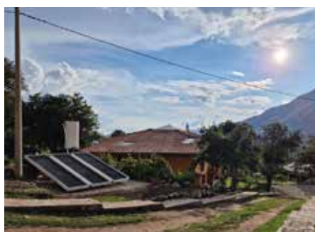
Neuinstallation und Renovierung
